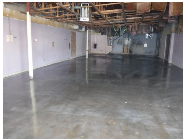
Photo 36 – Primer coat installed
