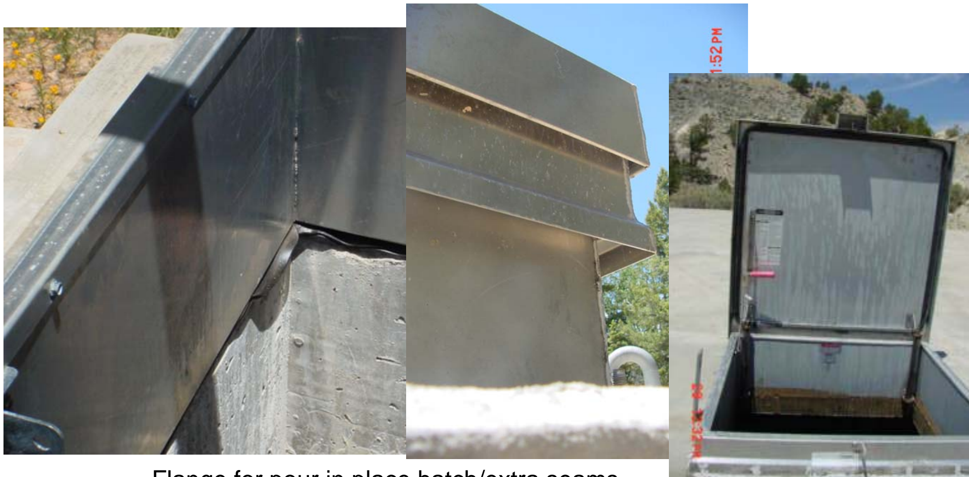
Flange for pour in place hatch/extra seams
